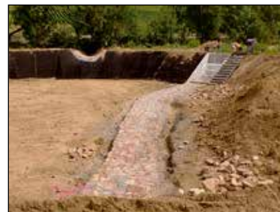
Regenrückhaltebecken „Misch- und Gewerbegebiet“
