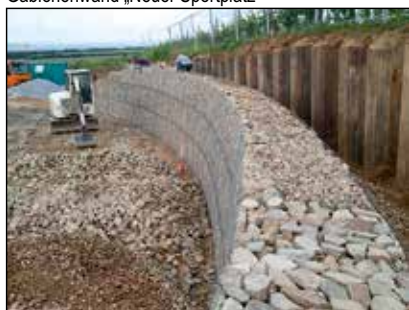
Gabionenwand „Neuer Sportplatz“
