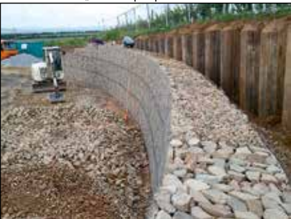
Gabionenwand „Neuer Sportplatz“
