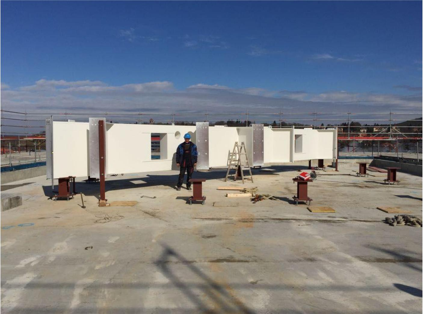
Hubschrauberlandeplattform auf dem Dach des Uniklinikums Erlangen, Montage diverser Stahlkonstruktionen, Schweißarbeiten.
