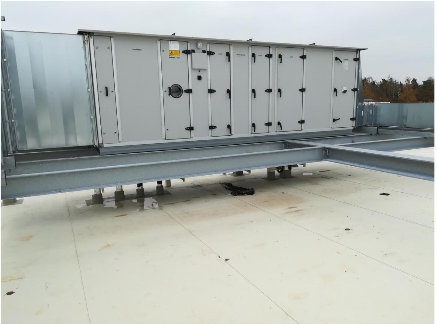
Unterkonstruktionen für Kälte- und Klimatechnik an diversen Standorten angefertigt und montiert.
