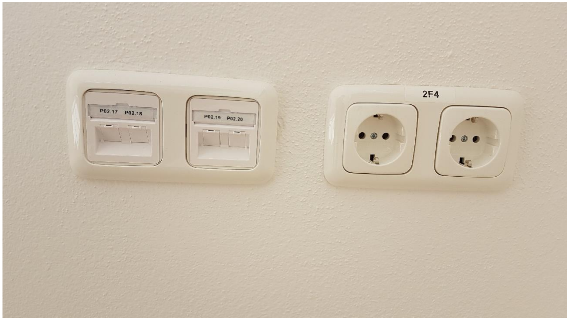
Strom- und Netzwerkverteilung in den Büros
