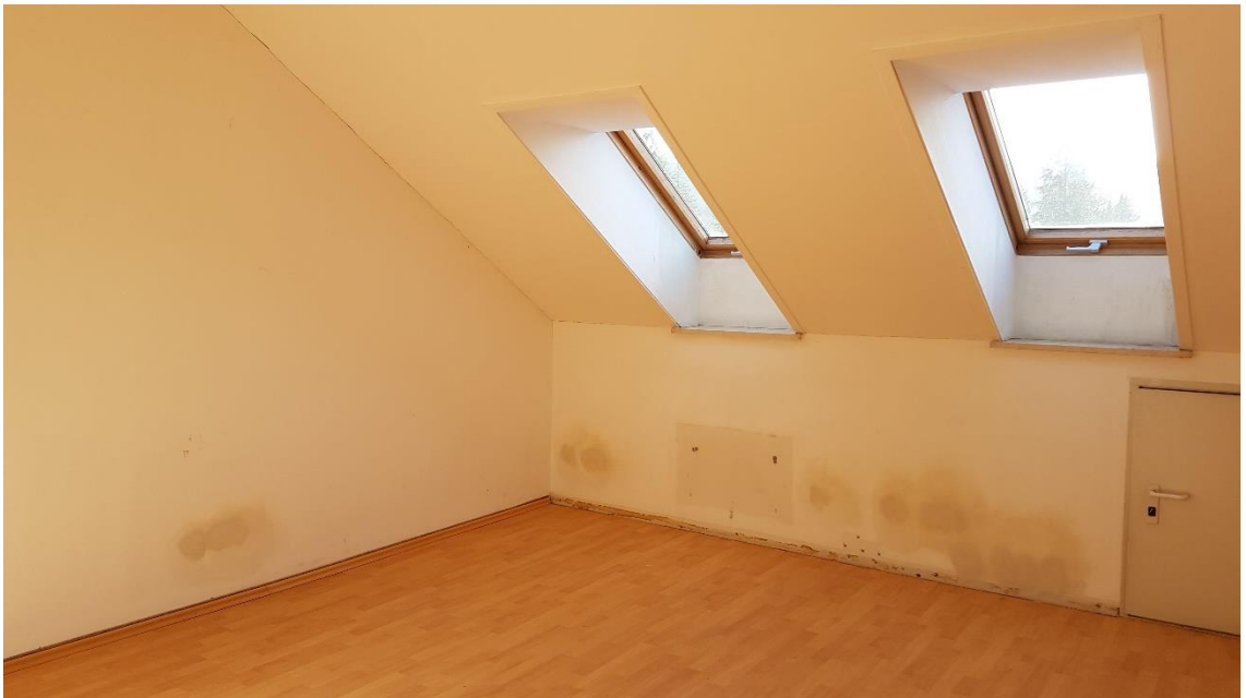
Archiv-/Lagerraum DG mit Ausblick zur Südseite
