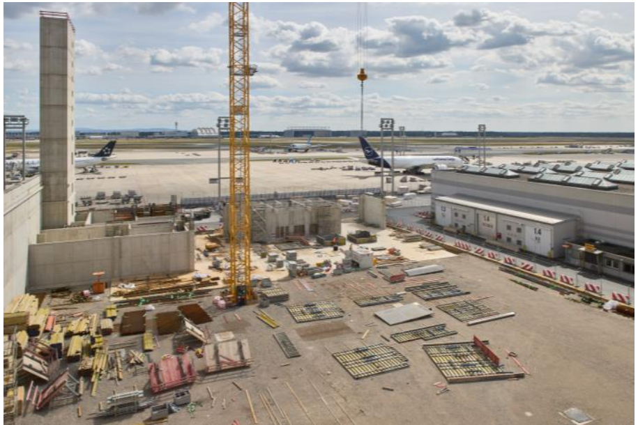
Während der Bauarbeiten wird die 24/7-Frachtabfertigung aufrechterhalten. Foto: Lufthansa Cargo
