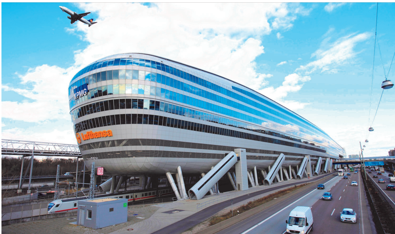
The Squire: Das markante Geschäfts- und Bürohaus über dem Fernbahnhof am Flughafen und neben der Autobahn ist Symbol für die Vernetzung. (Foto: Fraport)
