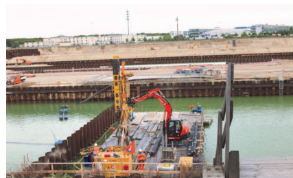
Um den Grundwasserspiegel nicht zu beeinträchtigen wird auch unter Wasser betoniert. (Foto: Theiss)
