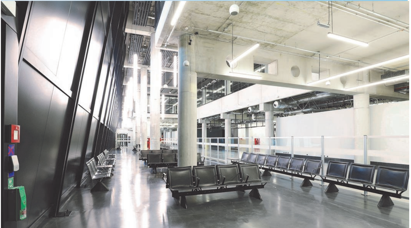
Flugsteig G von Terminal 3 ist schon weitgehend fertiggestellt. Er wird voraussichtlich 2026 gemeinsam mit dem Terminal 3 eröffnet. Foto: Fraport AG
