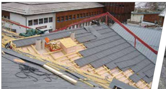
Charpenterie Buet - Architecte Neyrinck - Tignes (73)
