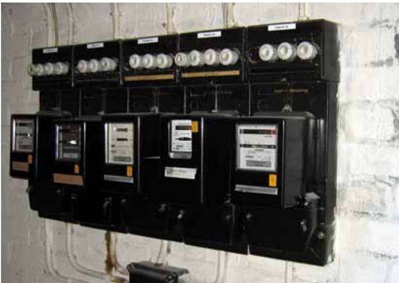
Bild 1: Nicht mehr zeitgemäße Zähleranlage – Anpassung oder Bestandsschutz?
