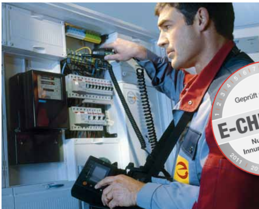
Bild 11: Mit modernen Messgeräten wird eine Anlagenprüfung vom Elektrofachmann durchgeführt.
