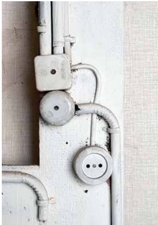
Bild 2: Es besteht Lebensgefahr – Bestandsschutz darf hier nicht geltend gemacht werden.
