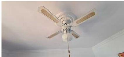
Chaque chambre est équipée d'un ventilateur de plafond. Cela peut être activé via la corde courte. Il existe 3 niveaux différents que vous pouvez parcourir en tirant plusieurs fois sur la corde courte. La lampe est commandée en conséquence via la longue corde. L'alimentation électrique est commandée via des commutateurs sur les lits ou sur la porte de la chambre.
