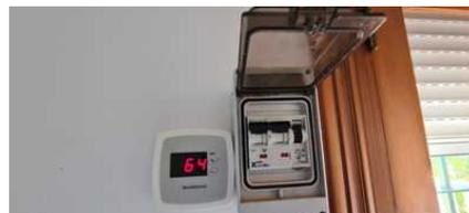
In der 1. Etage links neben der Terrassentür finden Sie ein Panel mit der aktuellen Wassertemperatur. Das Wasser wird durch einen Sonnenkollektor auf dem Dach beheizt. Falls die Temperatur im Winter nicht ausreicht, kann man mit den beiden Sicherungen eine Stromheizung dazuschalten. Im Sommer bitte keinesfalls betätigen!
