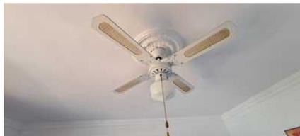
Jedes Zimmer ist mit einem Deckenventilator ausgestattet. Diesen kann man über das kurze Seil einschalten. Es gibt 3 verschiedene Stufen, die man über mehrmaliges Ziehen an dem kurzen Seil durchschaltet. Die Lampe wird dementsprechend über das lange Seil gesteuert. Die Stromzufuhr wird über Wechselschalter an den Betten bzw. an der Zimmertür gesteuert.
