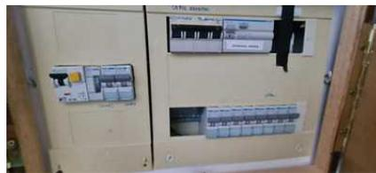
Direkt neben der Eingangstür finden Sie den Sicherungskasten. Falls eine Sicherung ausgelöst wird, kann man dies dort überprüfen und nach Beseitigung des auslösenden Problems die Sicherung wieder zurückstellen.
