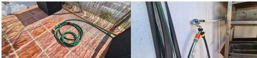
Die Wasserversorgung im Außenbereich erfolgt über zwei Wasser-Verteiler an der östlichen Hauswand (zwischen Außenküche und Treppe) und an der westlichen Hauswand (in Höhe der Wäschespinne). Die dort abgehenden Schlauchverbindungen lassen sich einzeln abstellen und sollten abends aus Sicherheitsgründen immer an den Haupthähnen geschlossen werden.
