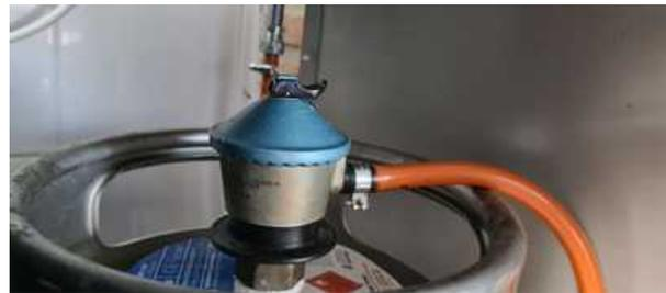
Die Außenküche ist ausgestattet mit einem Gasherd mit Backofen. Sobald dieser nicht in Benutzung ist, bitte am Druckminderer durch Umlegen des Hebels die Gaszufuhr unterbrechen. Ganz rechts unter der Arbeitsfläche finden Sie eine Ersatz-Gasflasche.
