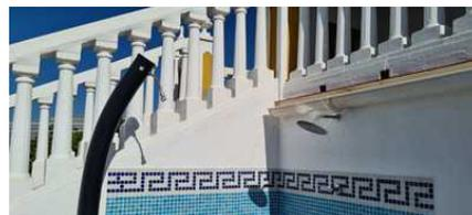
Die schwarze Außendusche neben dem Pool ist eine Solar-Dusche. Das Wasser im Rohr heizt sich durch die Sonne auf. Die Wasserzufuhr erfolgt über den Doppelhahn links neben der Treppe an der Außenküche. Bitte abends unbedingt abdrehen.
