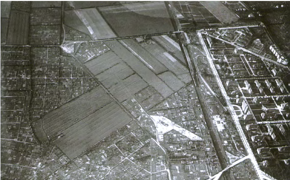
Luftaufnahme aus dem Jahr 1921/1922. Zwischen Kleingärten und Äckern ist die Vorbereitung für den Straßenbau – die Verlängerung der Habichtstraße – zu erkennen. Östlich befindet sich die Anlage des Krankenhauses.
