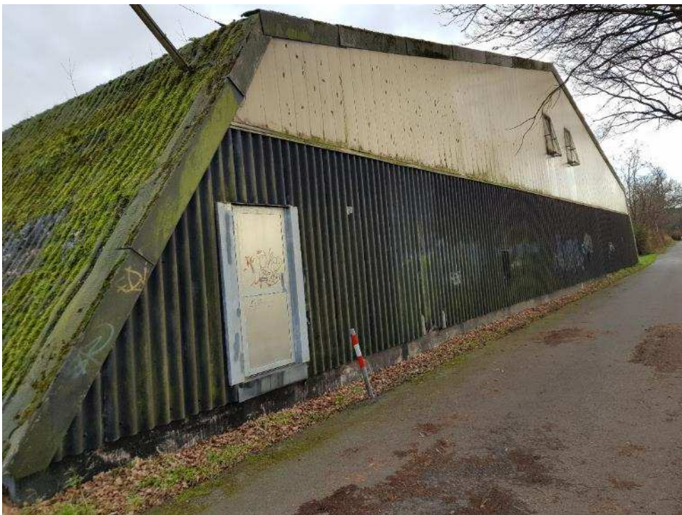
Bild 6: Ansicht der geschädigten Westfassade der Tennishalle, an der Fassade führt ein öffentlicher Weg vorbei
