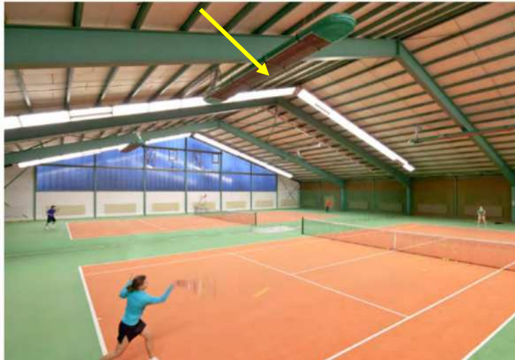
Bild 8: Gewünschte Wärmestrahlung durch Dunkelstrahler
