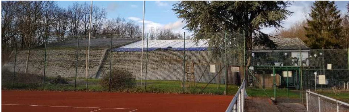
Bild 3: Ansicht der Tennishalle und des Clubhauses von Süden
