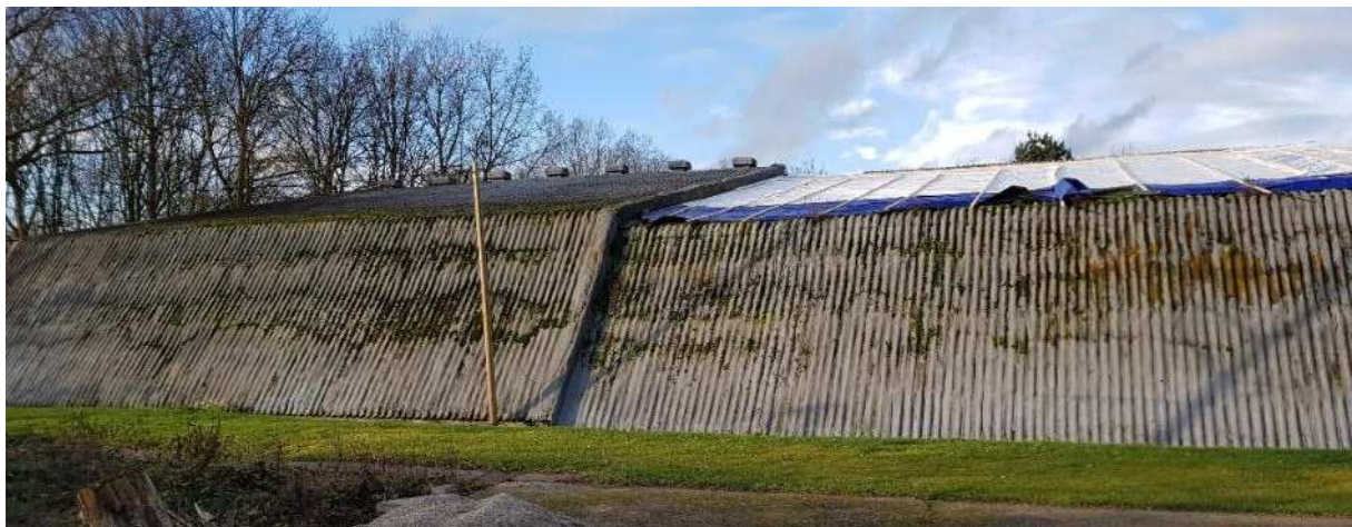
Bild 4: wie Bild 3, nähere Ansicht, die Südseite der Halle 1 ist notdürftig mit einer Plane abgedeckt
