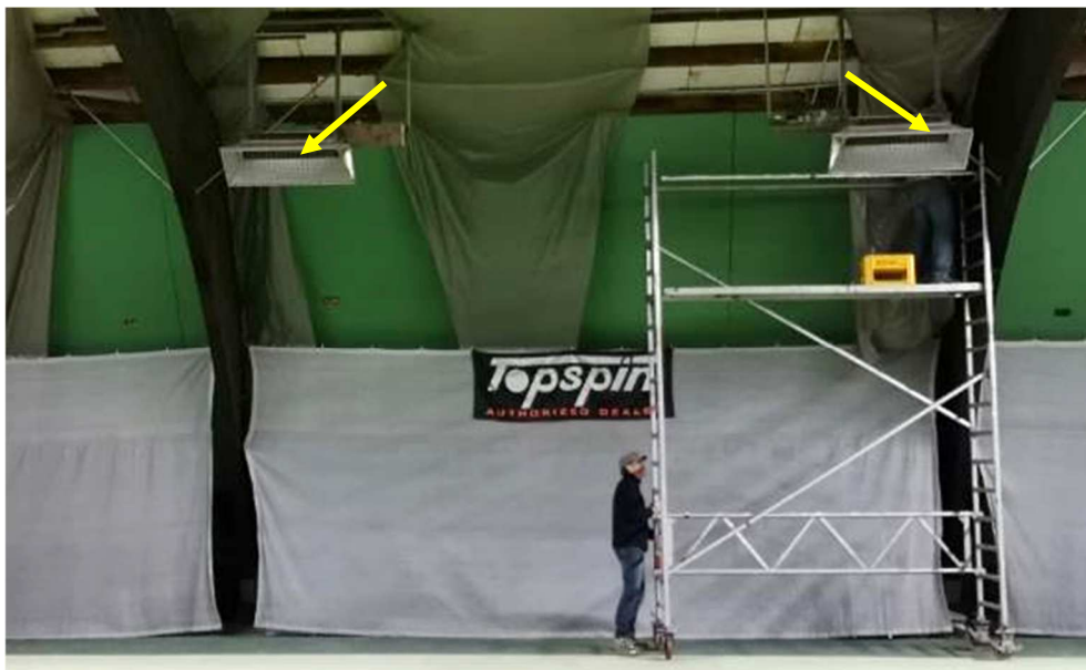
Bild 7: Derzeit installierte Infrarotstrahler
