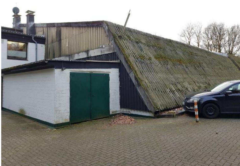
Bild 2: wie Bild 1, Blick entlang der Tennishalle
