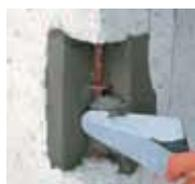
Aplicar **weber.tec hormiplus** con un paletín, rellenando y compactando la zona a reparar, en capas sucesivas de 1 a 5 cm, con un máximo de 10 cm por aplicación. La capa debe haber comenzado a endurecer antes de aplicar la siguiente.
