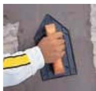
El acabado se realiza fratasando **weber.tec hormiplus** con una herramienta adecuada (fratás de plástico, madera, pórex...), o bien alisando con la llana.
