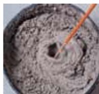
Amasar **weber.tec hormiplus** con 3-3,5 litros de agua limpia por saco, con un batidor eléctrico lento (500 rpm) durante unos 2 minutos, hasta obtener una consistencia plástica, pero sin que descuelgue de la paleta.
