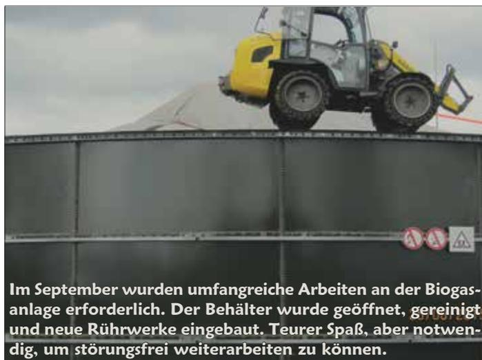
Im September wurden umfangreiche Arbeiten an der Biogasanlage erforderlich. Der Behälter wurde geöffnet, gereinigt und neue Rührwerke eingebaut. Teurer Spaß, aber notwendig, um störungsfrei weiterarbeiten zu können.
