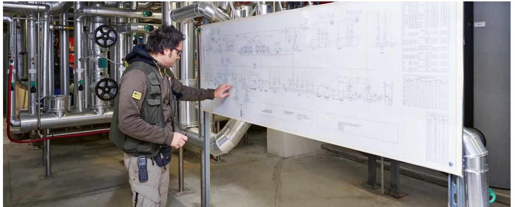
Im Technikraum des Aqualux: Die Effizienz der Gebäudetechnik macht vor allem die Möglichkeit des gleichzeitigen Heizens und Kühlens aus. Verantwortlich dafür sind zwei Multifunktions-Erdwärmepumpen, die nicht nur das Warmwasser für die Klimatisierung und die Beheizung der Pools erzeugen, sondern auch das teilweise Aufheizen von Brauch-Warmwasser. Zusätzlich wird das Kühlsystem durch einen Kaltwassersatz mit Turboverdichtern in Kombination mit einem Kühlturm ergänzt.
